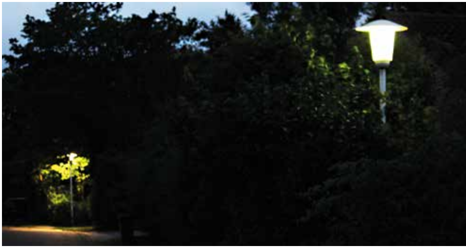
Eingewachsenen Lampen, die auch nicht optimal platziert sind, um die Straße auszuleuchten.
